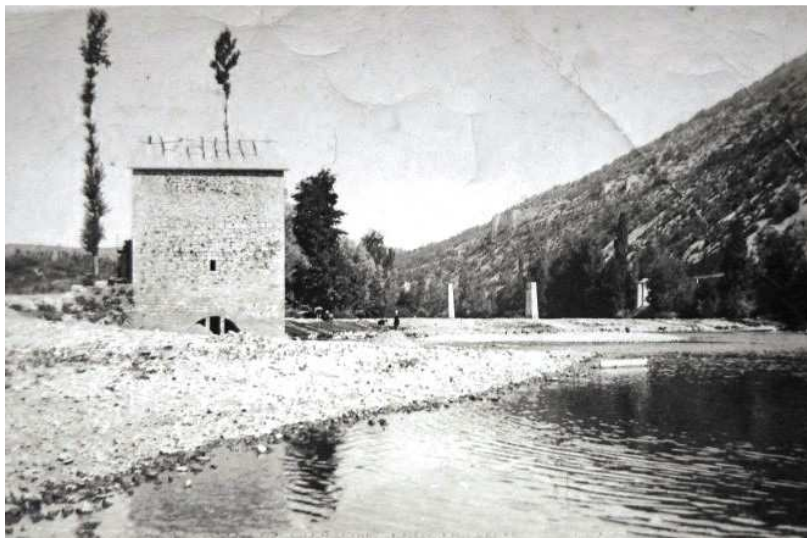
Passerelle de Cazals en construction en 1930
