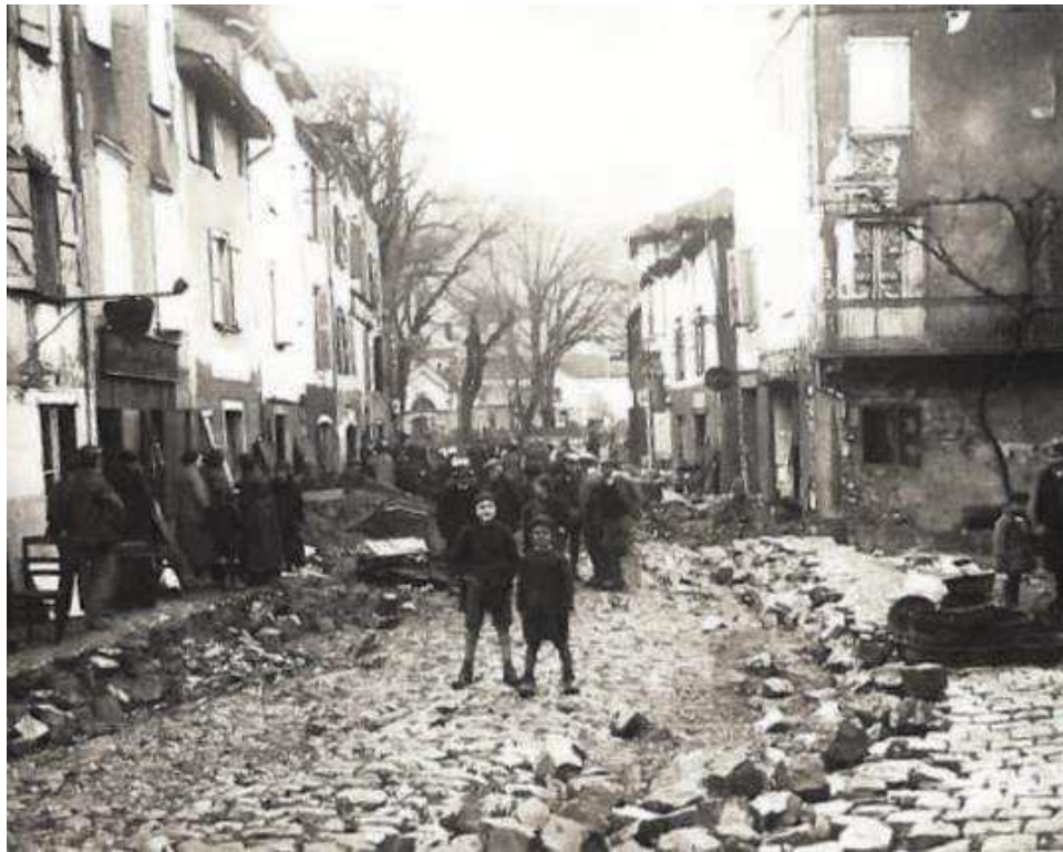
Les dégâts causés par les inondations de 1930 sur le boulevard des Thermes depuis la place St Michel
