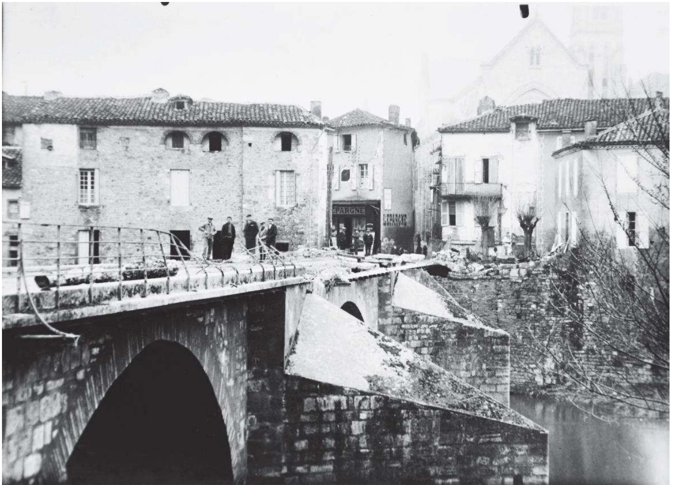
Le pont de la ville a été endommagé par l'eau et les débris qui l'ont recouvert lors de l'inondation de 1930
