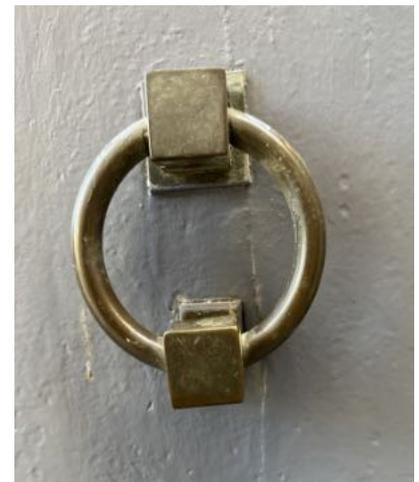
Toutes selon le même principe : une plaque plus ou moins ajourée fixée sur la porte, une poignée qui permet de tirer la porte et de frapper le bois par effet de marteau (avec un renflement en partie inférieure) et une articulation (un tourillon) entre les deux parties.
